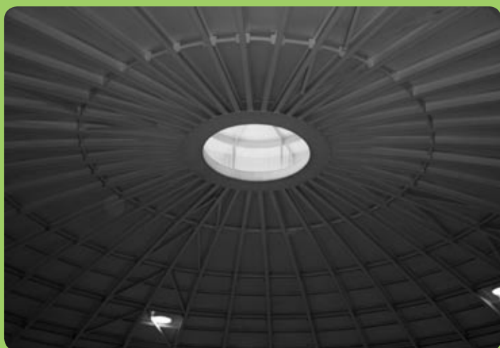
En bild från insidan av gasklockan för koloxid.
